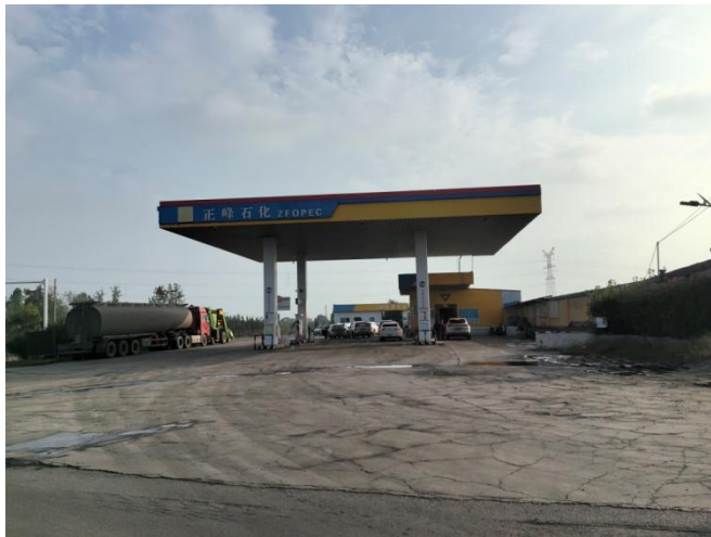
正峰石化加油站
